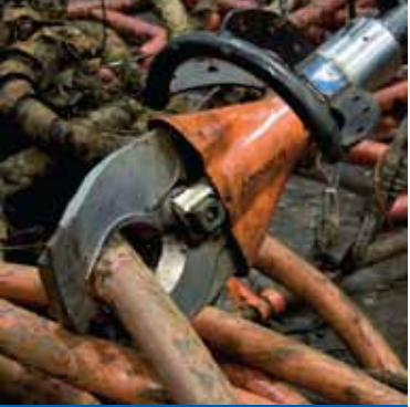
Kablo kesme işlemi
