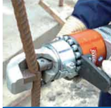
İnşaat demiri kesme işlemi
