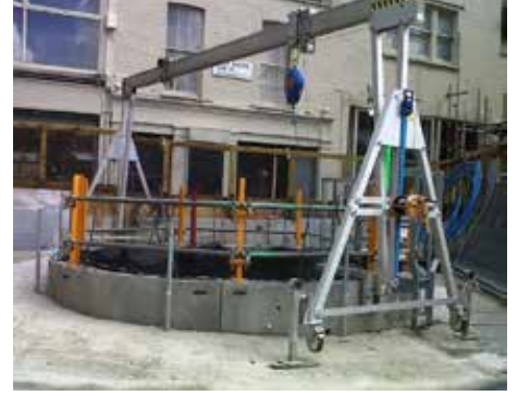
Kurtarma vinci opsiyonlu portal vinç, çalışma sahasından emniyetli mesafede kurtarma operasyonu sağlar.
